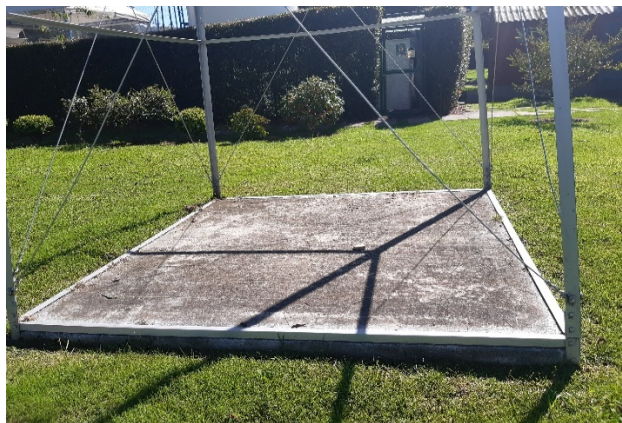
Foto No. 5. Placa en concreto – base molino de viento
